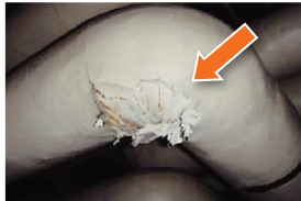
石綿含有断熱材、保温材、 耐火被覆材 [レベル2]
