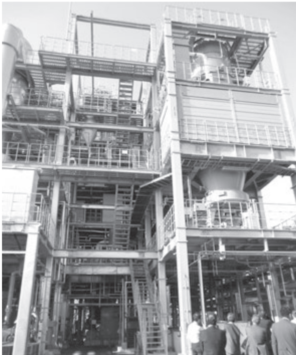
汚泥燃料化施設
